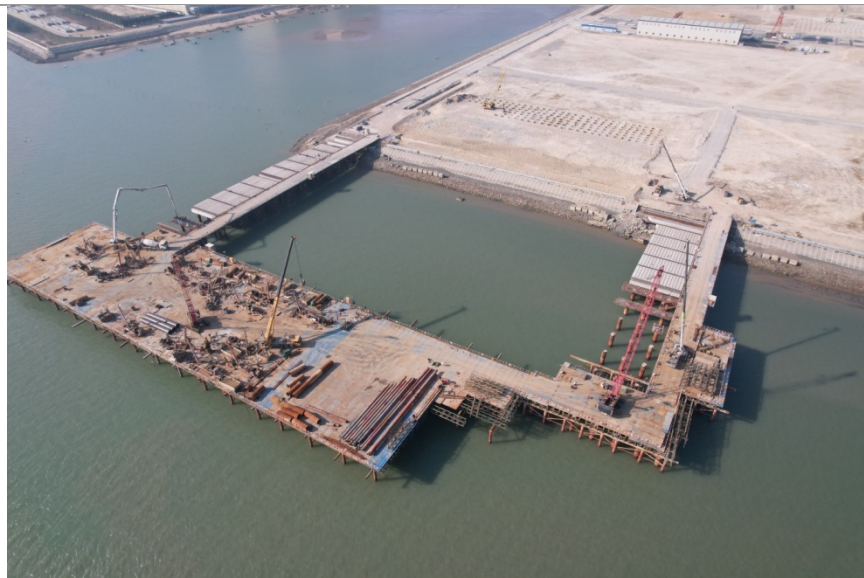
a 1#、2#泊位工程正在施工的码头和施工平台
