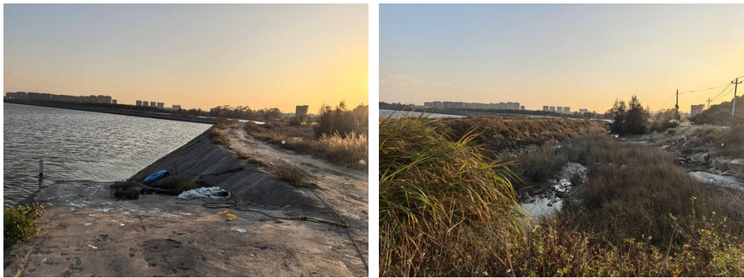
照片 2.2-3 21 号池塘内侧围堤照片
