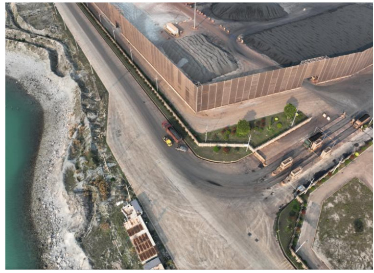
b 福州港松下港区疏港公路及配套工程(海域段)
