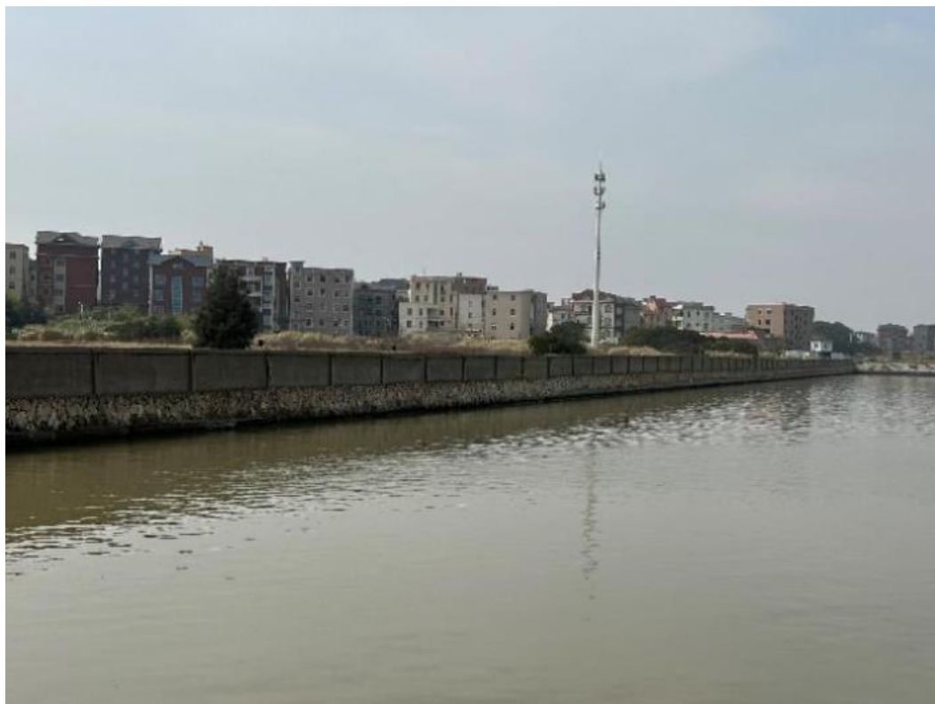
图 2.1-12 直立式（A1+260~A1+630 段）海堤现状照片
