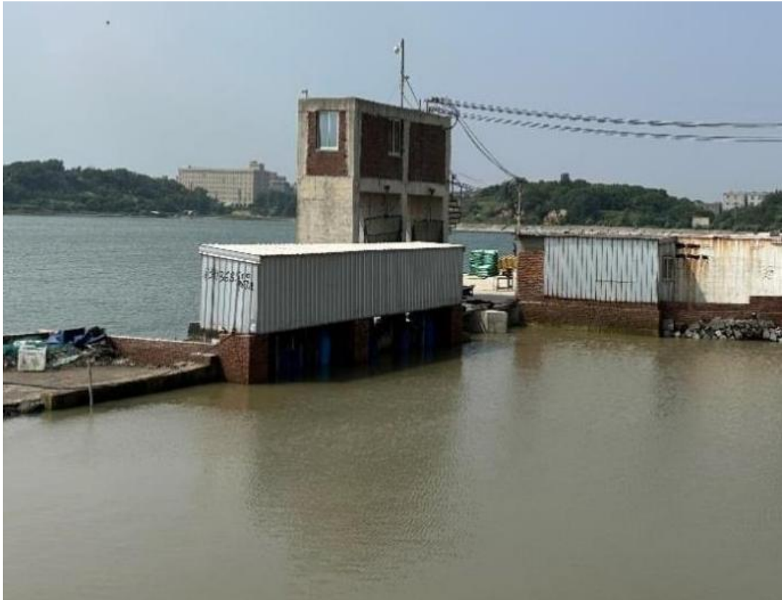
图 2.1-8a 西北角现状水闸及涵洞
