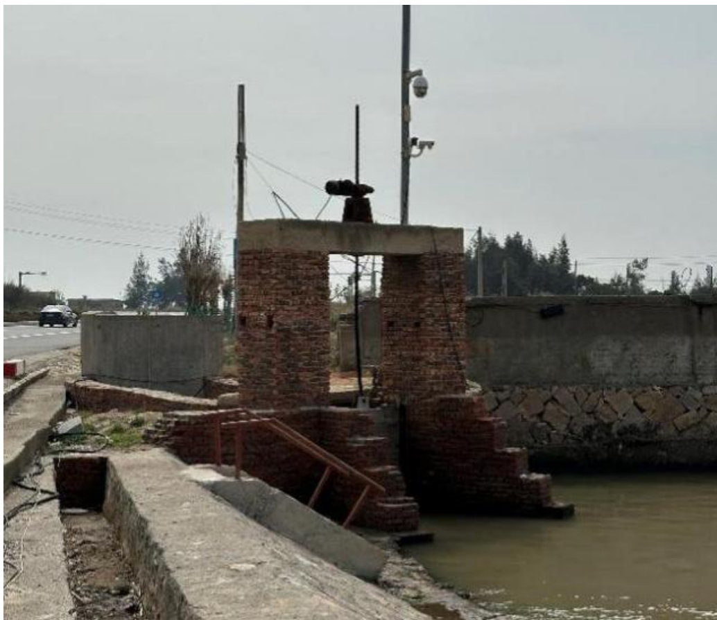
图 2.1-9a 东南角现状水闸及涵洞
