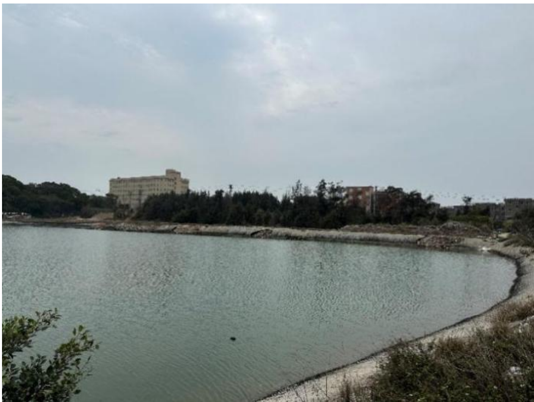
图 2.1-11 斜坡式（A0+000~A1+260 段）海堤现状照片
