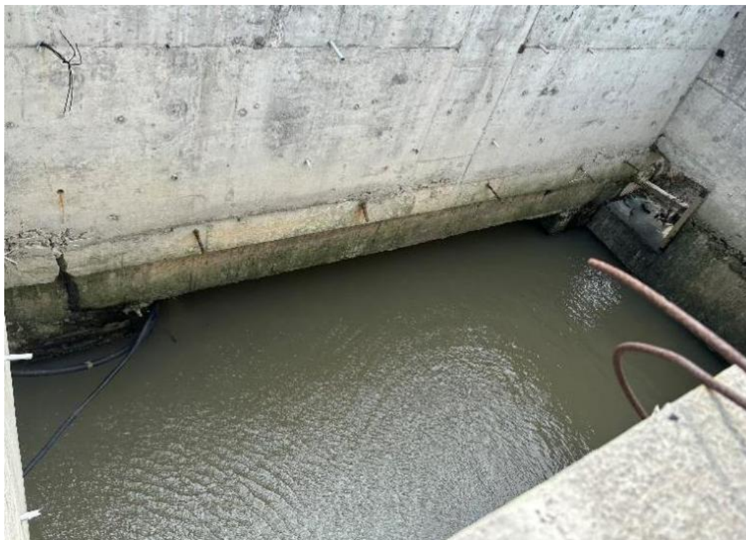
图 2.1-9b 东南角现状水闸及涵洞
