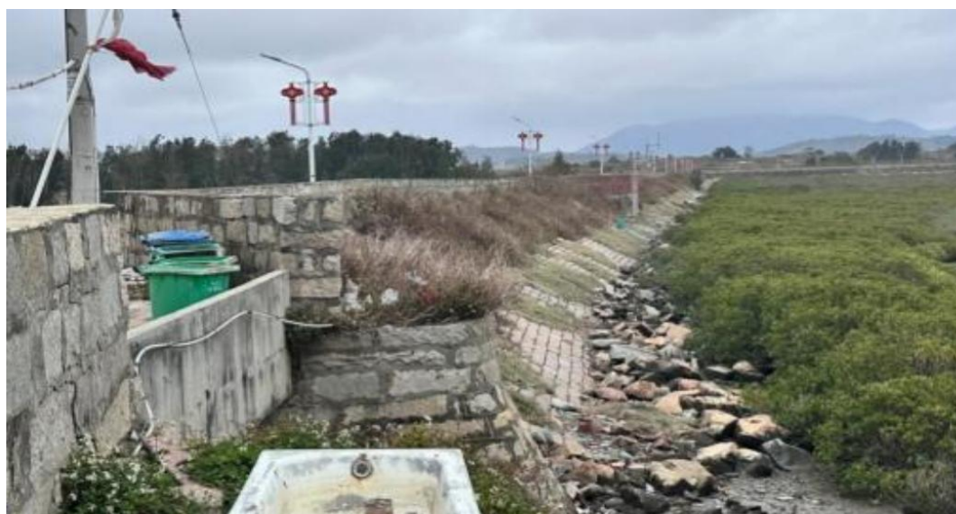
图 2.1-6 长安海堤外侧坡面
