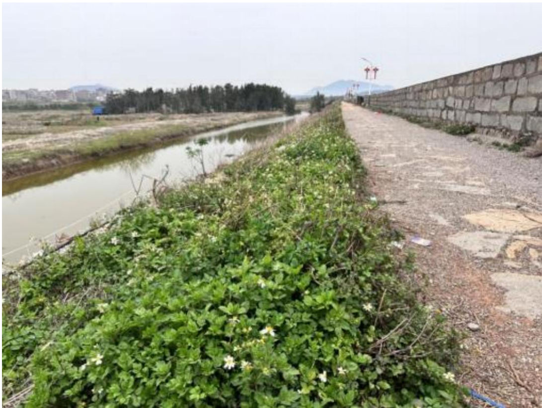
图 2.1-7 长安海堤内侧坡面
