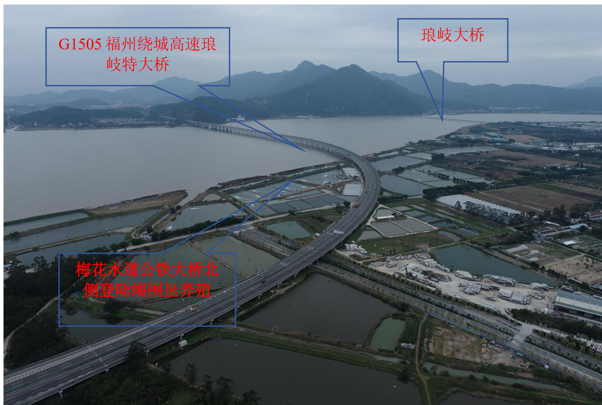
图 5.1-2a 梅花水道公铁大桥北侧登陆端围垦养殖的分布情况
